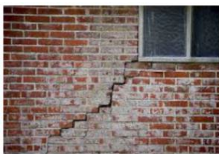
Zettingsscheur
