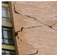
Constructiescheur
